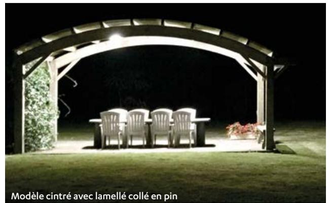
Modèle cintré avec lamellé collé en pin
