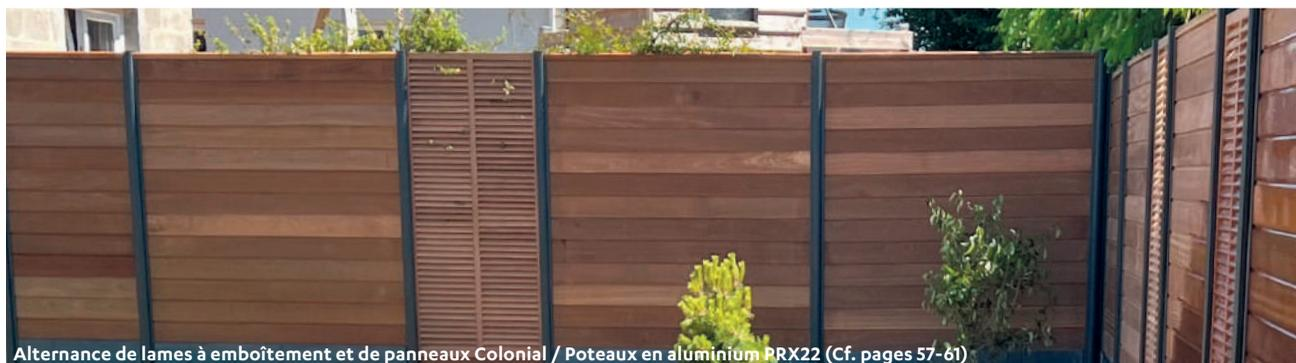
Alternance de lames à emboîtement et de panneaux Colonial / Poteaux en aluminium PRX22 (Cf. pages 57-61)
